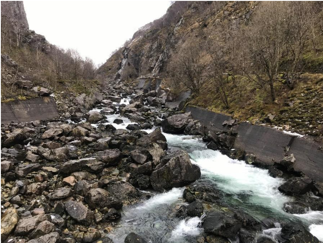
Figur 4: Tiltak 3, ca 250 meter oppstrøms bro.
