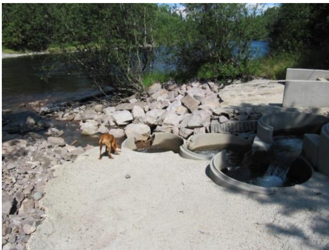
Fig. 29. Betongringer med åpning montert nedstrøms kulvertutløp. Utløpet til Numedalslågen til venstre i bildet (Foto: Sigrun Børresen).
