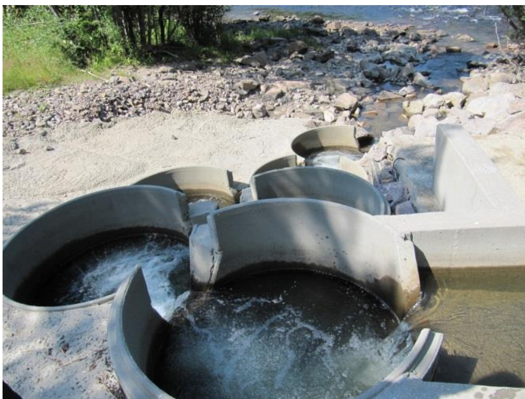
Fig. 27. Betongrør med tilpassede åpninger utgjør fisketrappa i Hemselva (Foto: Sigrun Børresen).
