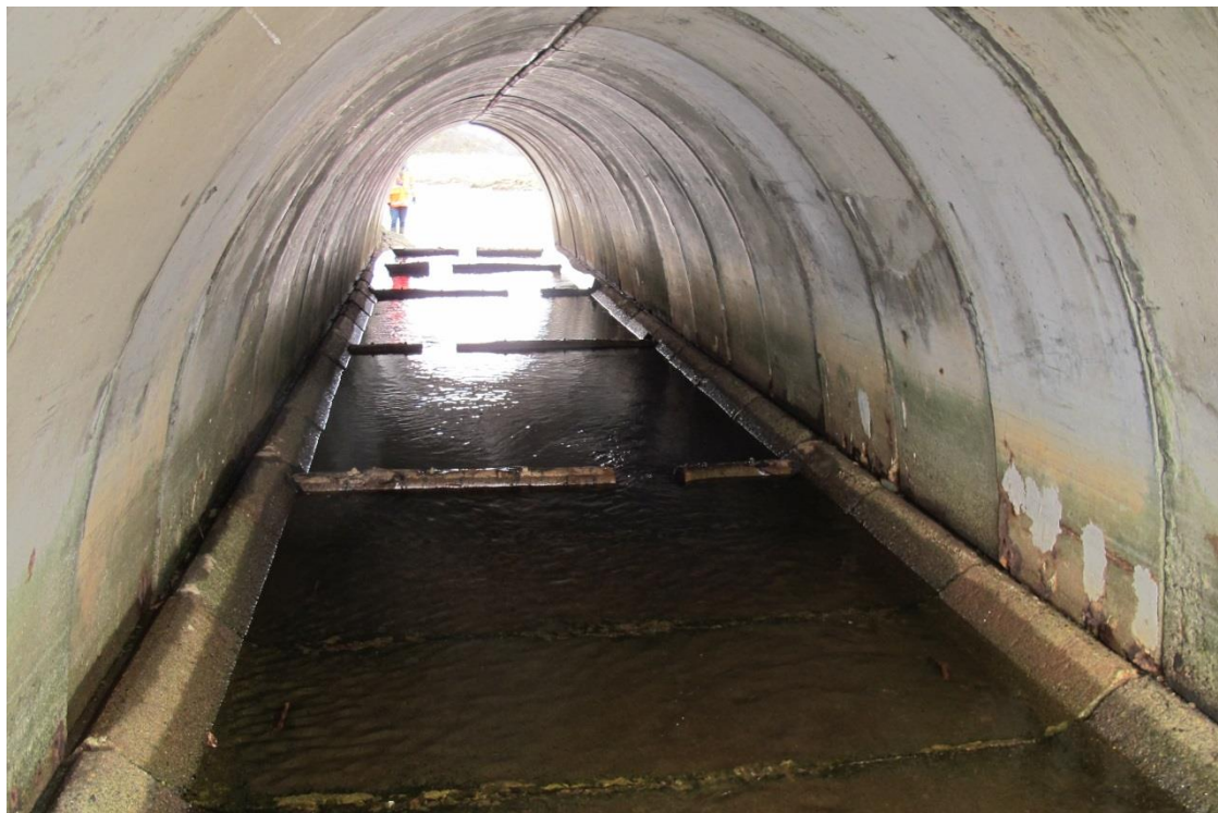
Fig. 61. Osepestokkene bremser vannhastigheten inne i kulverten og gjør oppvandringen for fisk lettere. Bildet er tatt på fjære og ved lav vannføring (Foto: Øyvind Haugland).
