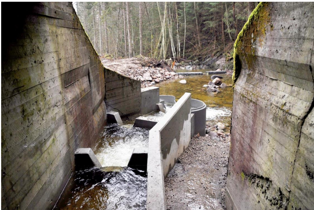
Fig. 35. Betongrør med åpen kant ved utløpet av laksetrappen. Bildet viser laksetrappen (til venstre) og vandrekanal for andre dyr på høyre side (Foto: Statens vegvesen Region sør).
