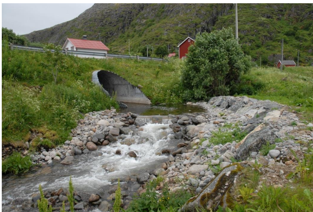
Fig. 68. Terskel anlagt nedstrøms kulvertutløpet gjør at vannspeilet står inn i kulverten og letter vandringen for fisk (Foto: NVE Region nord).
