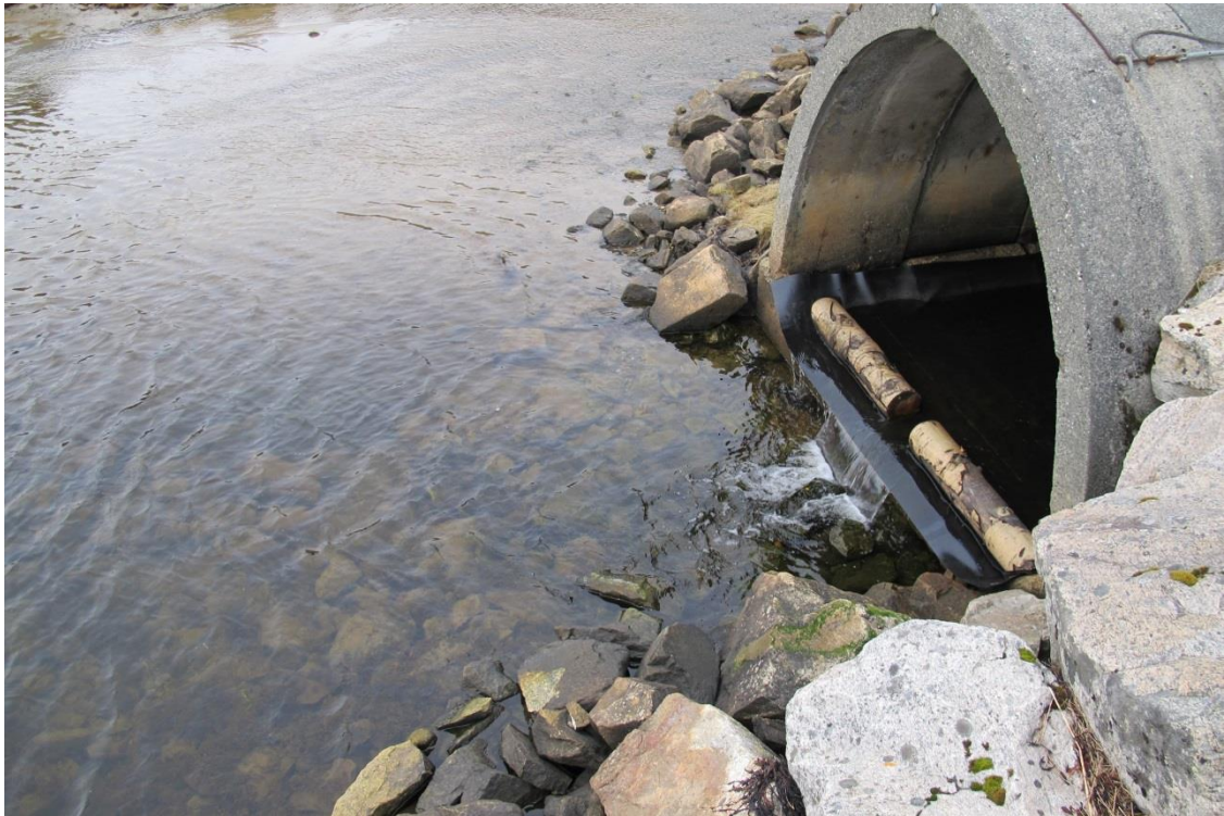
Fig. 60. Osepestokker er montert ved utløpet og inni kulverten. På flo står vannet inn i kulverten. Bildet er tatt på fjære sjø. Forsterket med duk ved utløpet (Foto: Øyvind Haugland).
