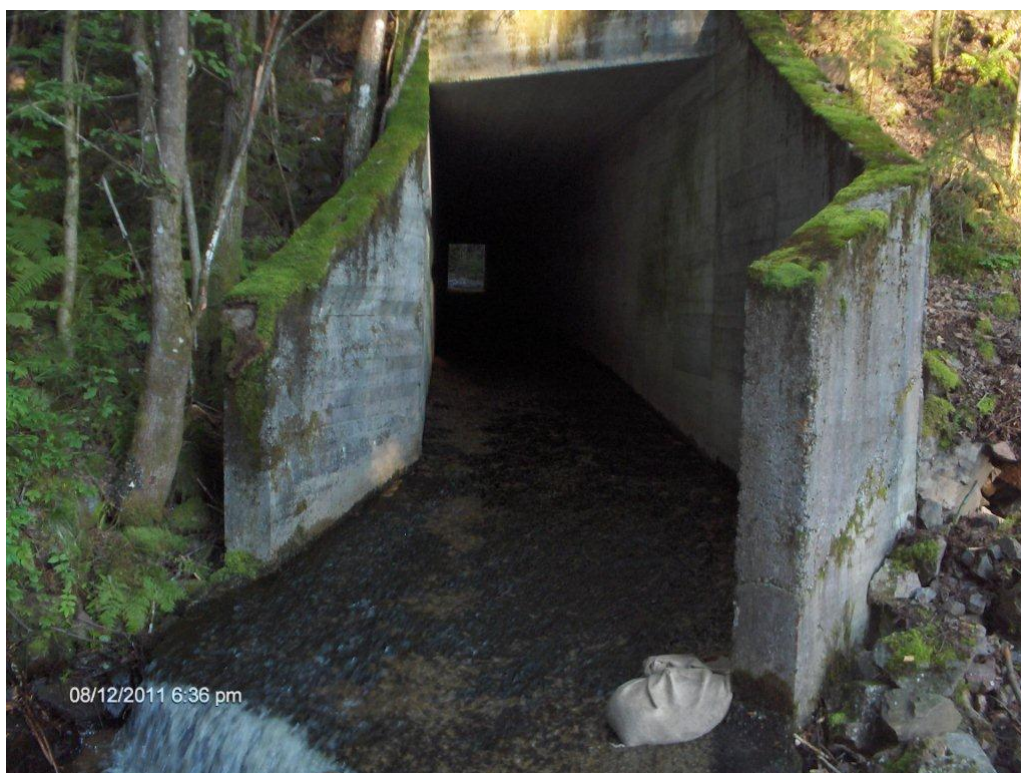
Fig. 32. Flat betongkulvert i Sarumelva. Høy vannhastighet gjennom kulverten og vanskelige vandringsforhold for fisk (Foto: Torleiv Inge Kili).
