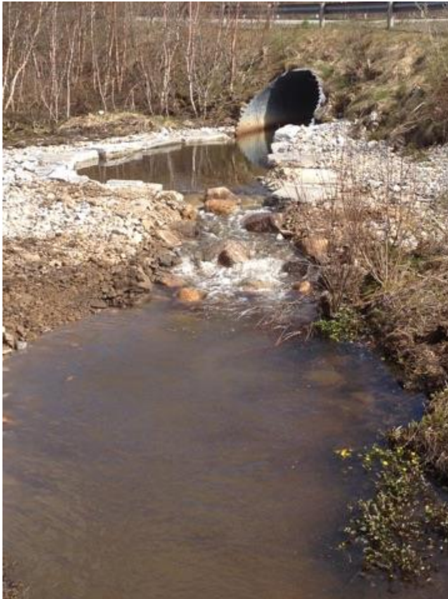
Fig. 64. Solid steinplastring langs sidene og terskel etablert på brekket. Vannspeilet står inn i kulverten og resulterer i gode vandringsforhold for fisk. I fiskerennen opp til terskelbassenget er steiner strategisk plassert med hensikt å bryte vannstrengen og lette vandringen for fisk opp i bassenget (Foto: Kenneth Fox).
