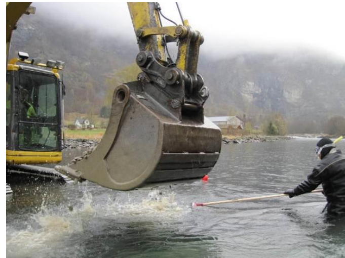
Figur 4 Dykker har utvalgt et egnet sted for grusutlegget og anviser gravemaskinførerens
