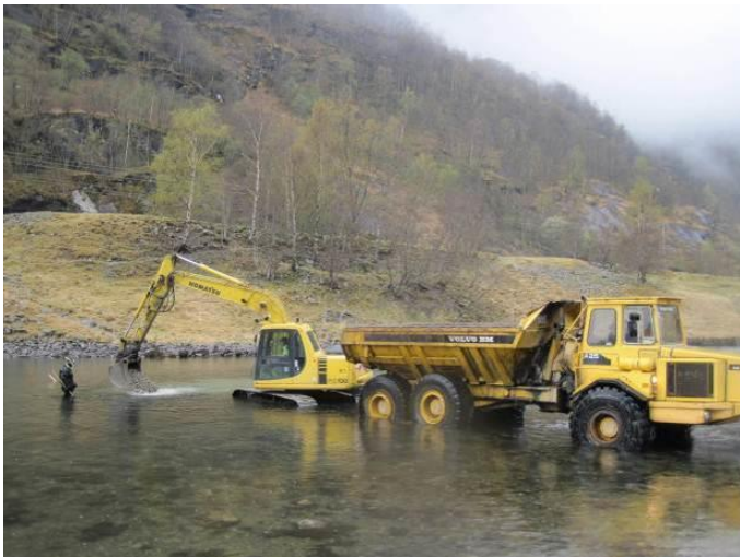
Figur 3 Grusutlegging ved Skaim 2010
