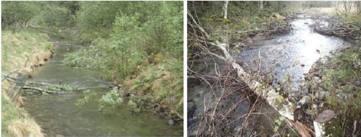
Fig. 53 Trær utlagt og festet i Tokvamsbekken, et sideløp i Aurlandselva.
