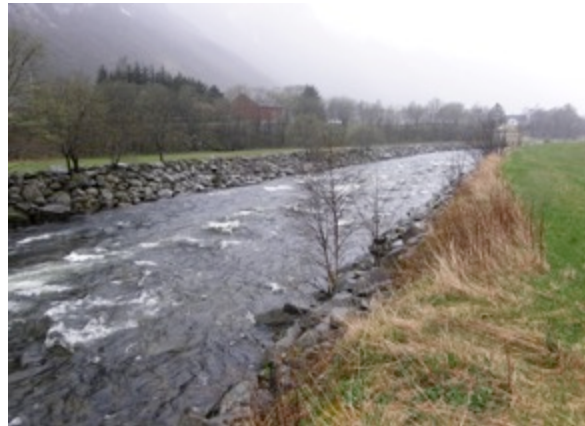
OG "MANGLENDE" KANTVEGETASJON
