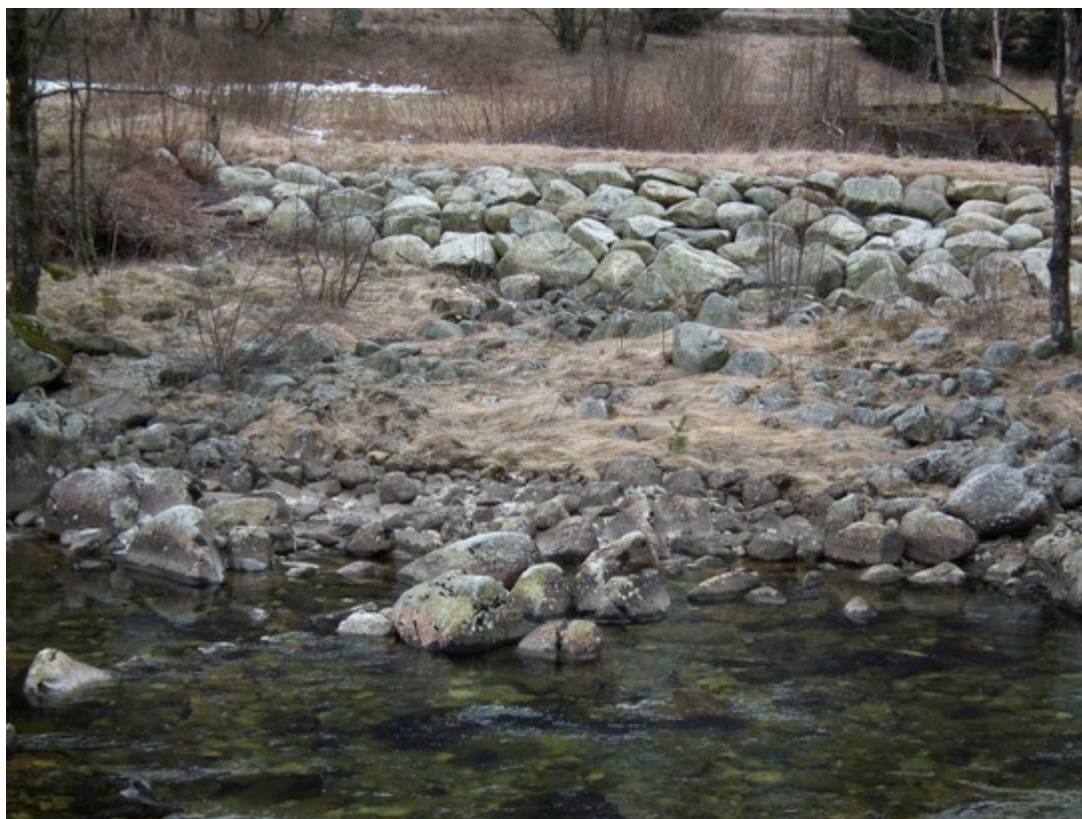
EKSEMPEL PÅ FYSISK INNGREP, HER ER ET OVERLØP / SIDELØP TØRRLAGT VED Å ETABLERE DEMNING
