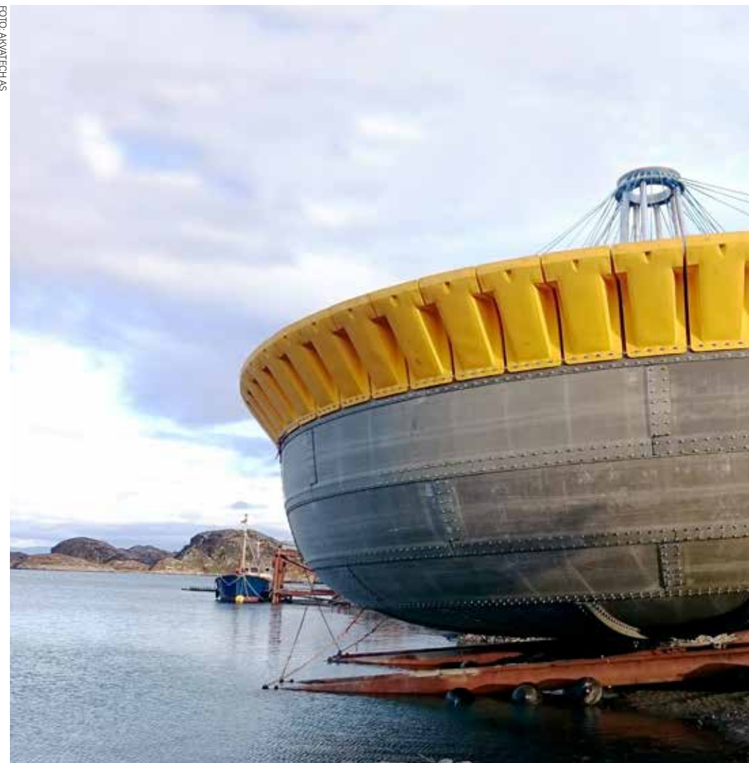
Oppdrett av laks i lukkede merder ser ut til å være en svært effektiv metode for å bekjempe lakselus. Fordi miljøforholdene kan kontrolleres bedre, og særlig på grunn av god vannstrøm og trening av fisken kan det være mulig å få raskere vekst i lukkede merder enn i åpne. Oppsamling og gjenbruk av slam er også en viktig fordel ved lukket merdteknologi. Bildet viser en semilukket merd fra AkvaTech.
