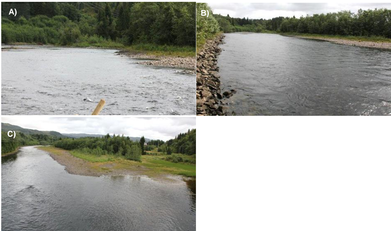
Figur 10. Bilder tatt 28. august av området hvor det er ønskelig flytte elveforbygning og åpne et sideløp. A) området mellom utløpet av sideløp og nytt sideløp. Øverst t.h. viser område hvor nytt sideløp starter, og nederste bildet viser området hvor sideløpet er tenkt å munne ut i hovedelva.
