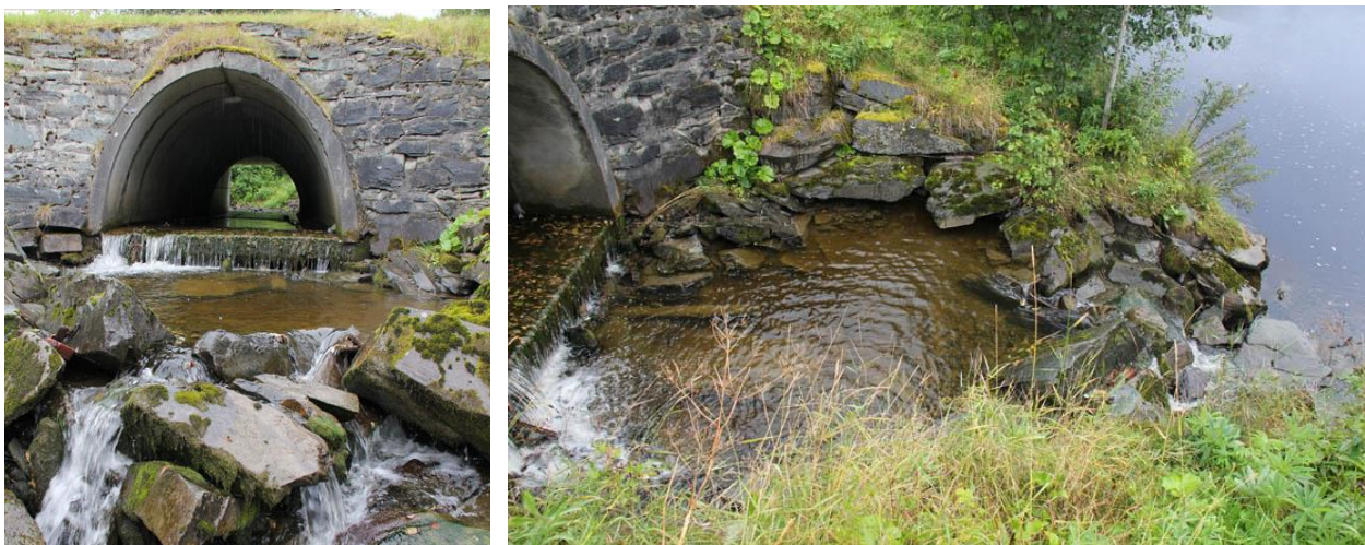
Figur 4. Bildene viser Kvernmobekkens utløp gjennom kulverten, fall ved utløp i kulp og steinsetting ved utløp i Stjørdalselva.
