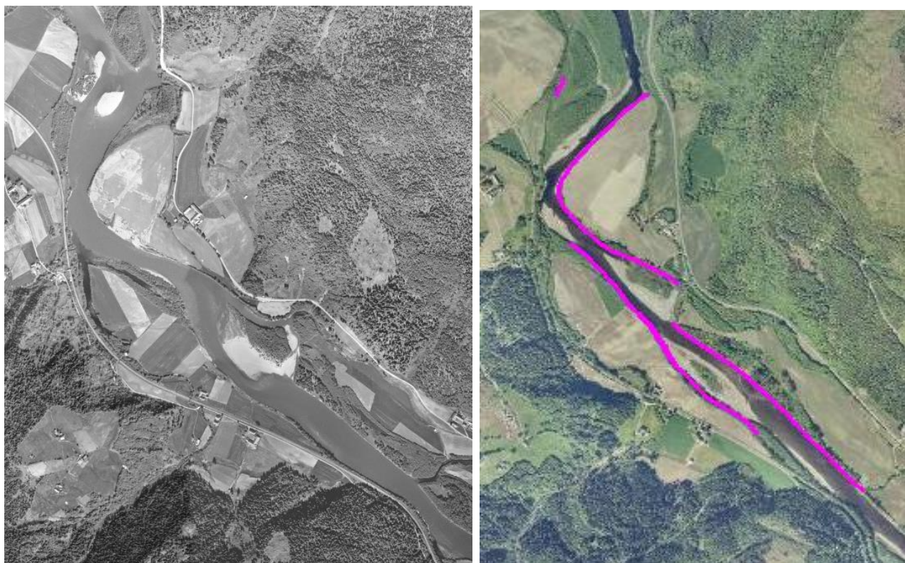
Figur 39 Flyfoto tatt i 1955 (t.v) og i 2010 (t.h) over området ved Ingstad/Einang som viser hvordan sikringstiltak/forbygninger (markert med røde linjer) har påvirket elveløpet.
