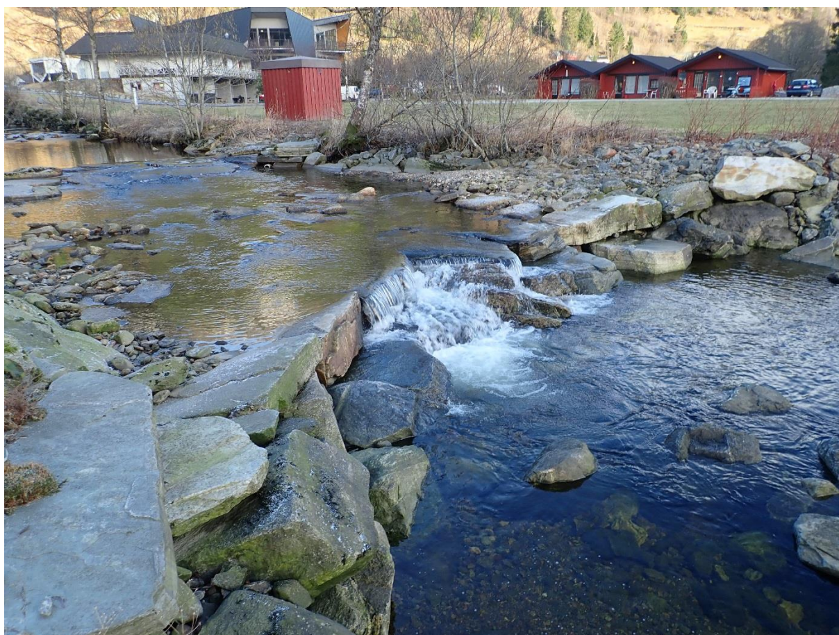
Figur 1. Bildet viser den nederste terskelen i Bærelva.
