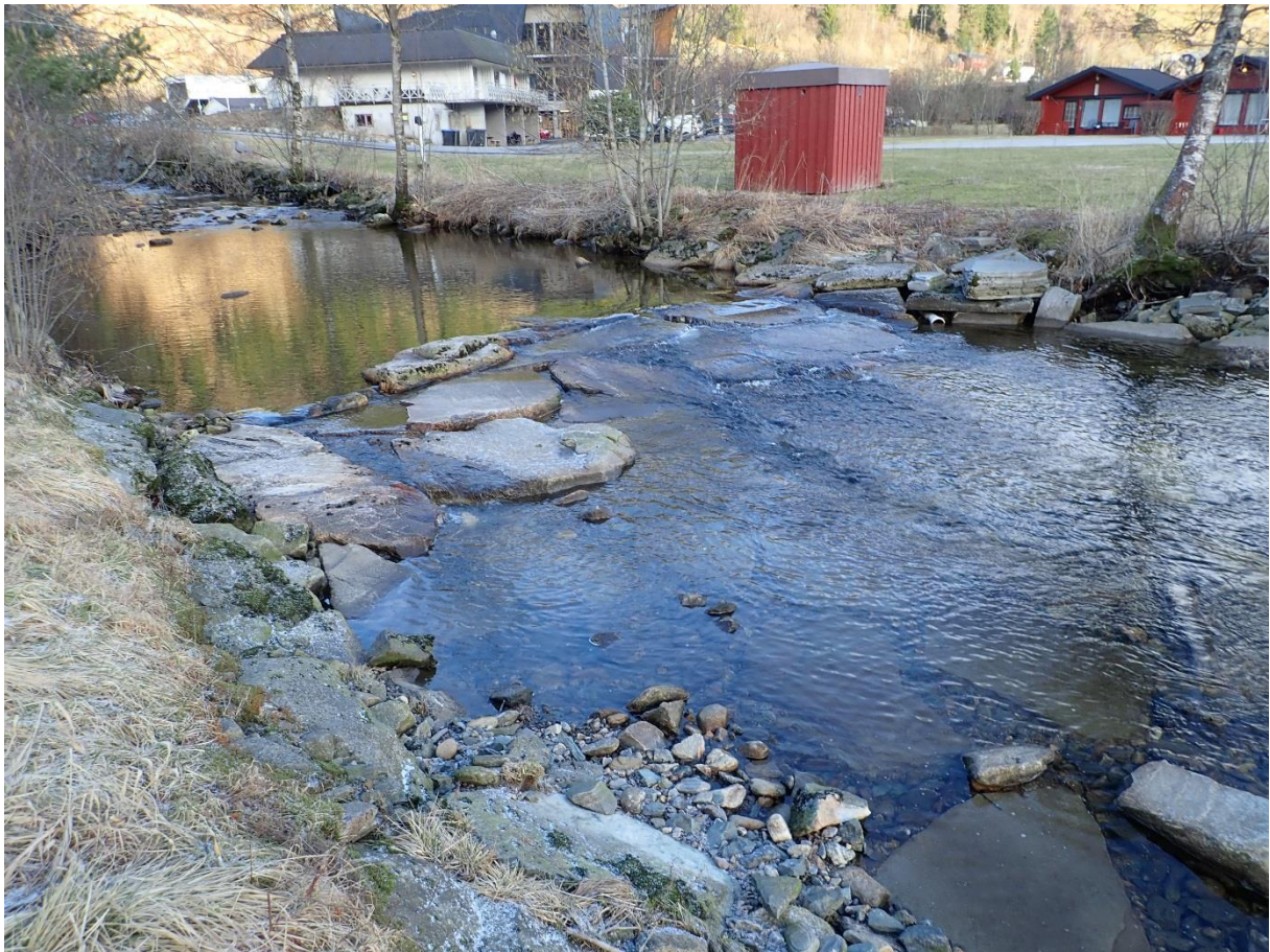
Figur 2. Bildet viser terskel nummer 2 i Bærelva, samt de bunnstabiliserende blokkene nedstrøms.
