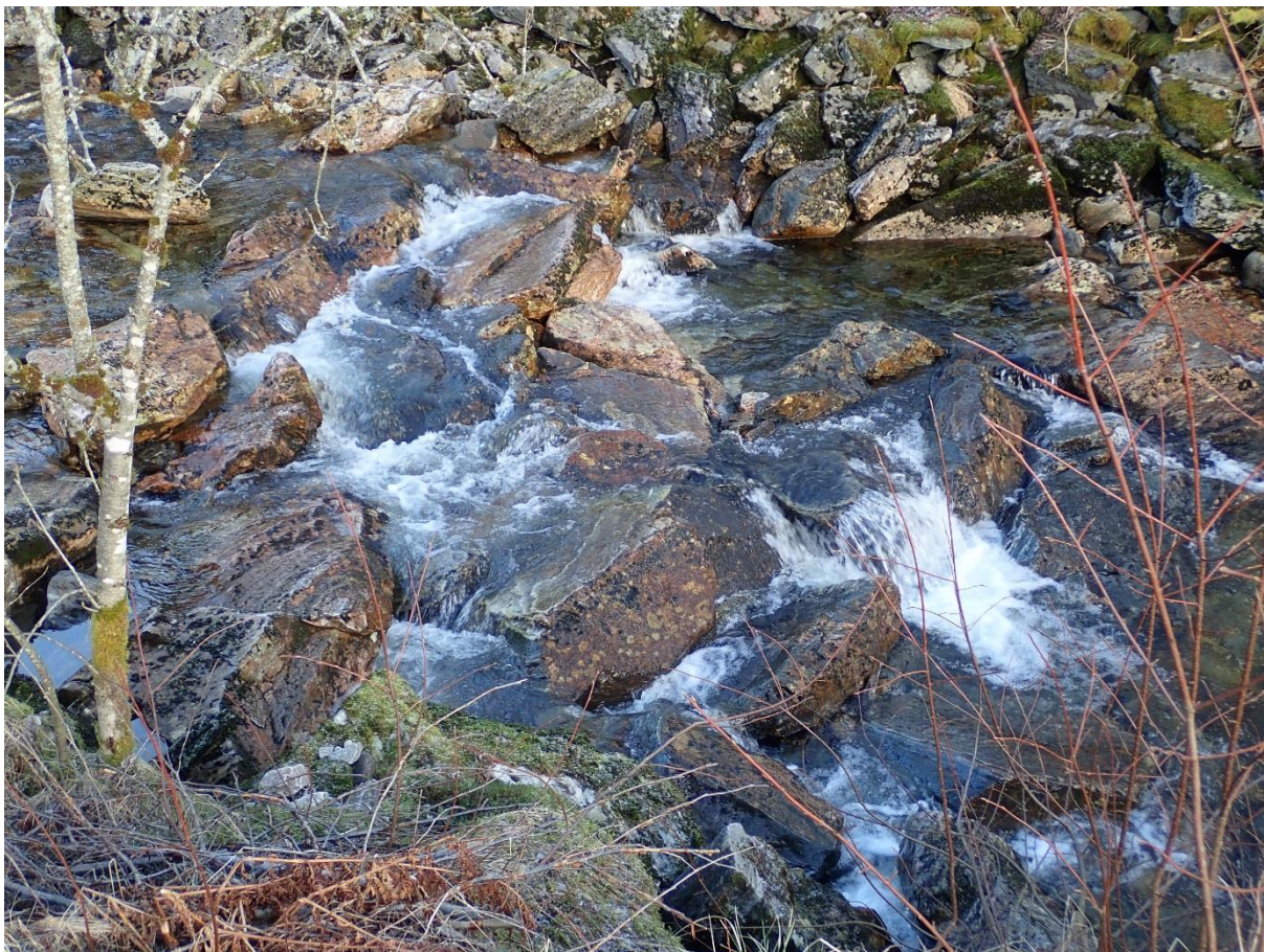
Figur 4. Den andre terskelen oppstrøms Rv. 5. Denne er utformet som en slags steinrøys av blokker og er passerbar som et stryk for laksefisk.
