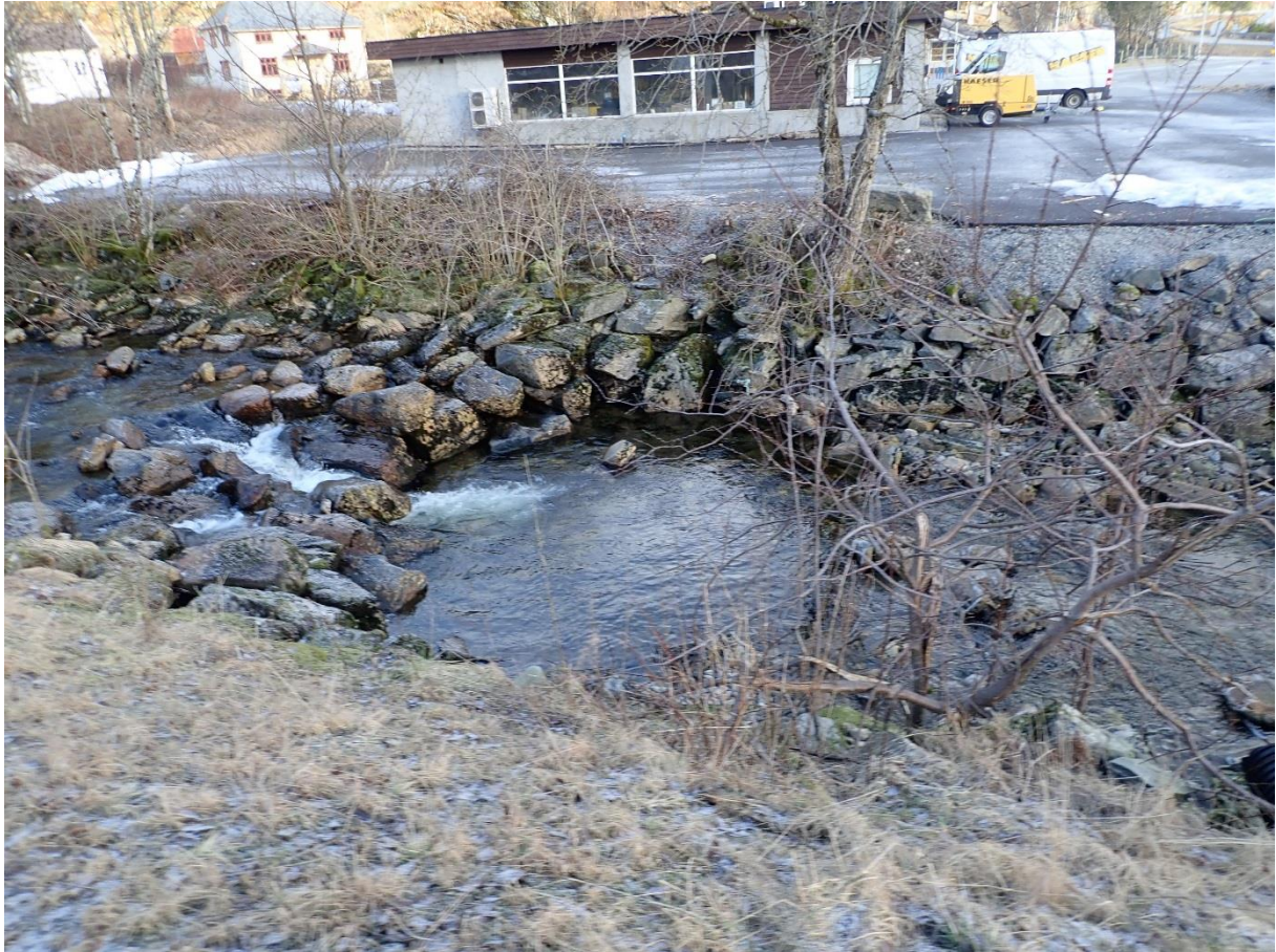
Figur 3. Den første terskelen oppstrøms Rv. 5. Terskelen har definert lavvannsrenne og er passerbar for fisk på de fleste vannføringer. Hølen nedstrøms terskelen utgjør også en standplass for voksen fisk.
