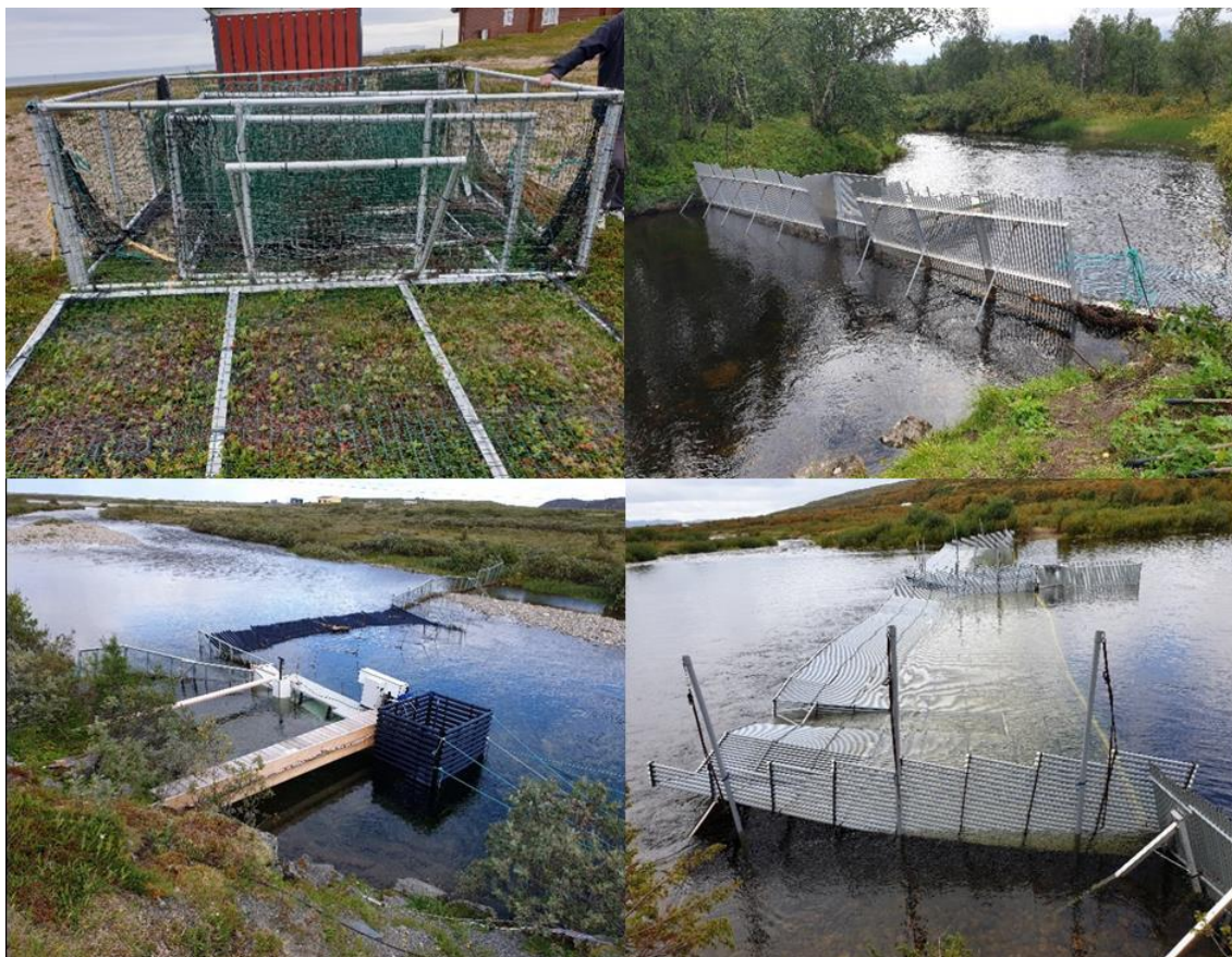
Bildeserie 1. I Finnmark er det benyttet ulike felleløsninger for å fange pukkellaks. I Komagelva (øvre venstre bilde) er det benyttet ledegjerder og fangstkasse bygd av netting, i Karpelva (øvre høyre bilde) er det benyttet en ristfelle med aluminiumsrør, i Storelva i Kongsfjord (nedre venstre bilde) er det benyttet en kombinasjon av flytende rør og vertikale rister, og i Vestre Jakobselva (nedre høyre bilde) er det benyttet en USA-produsert flyteristfelle. Alle foto: Gunnbjørn Bremset, NINA.
