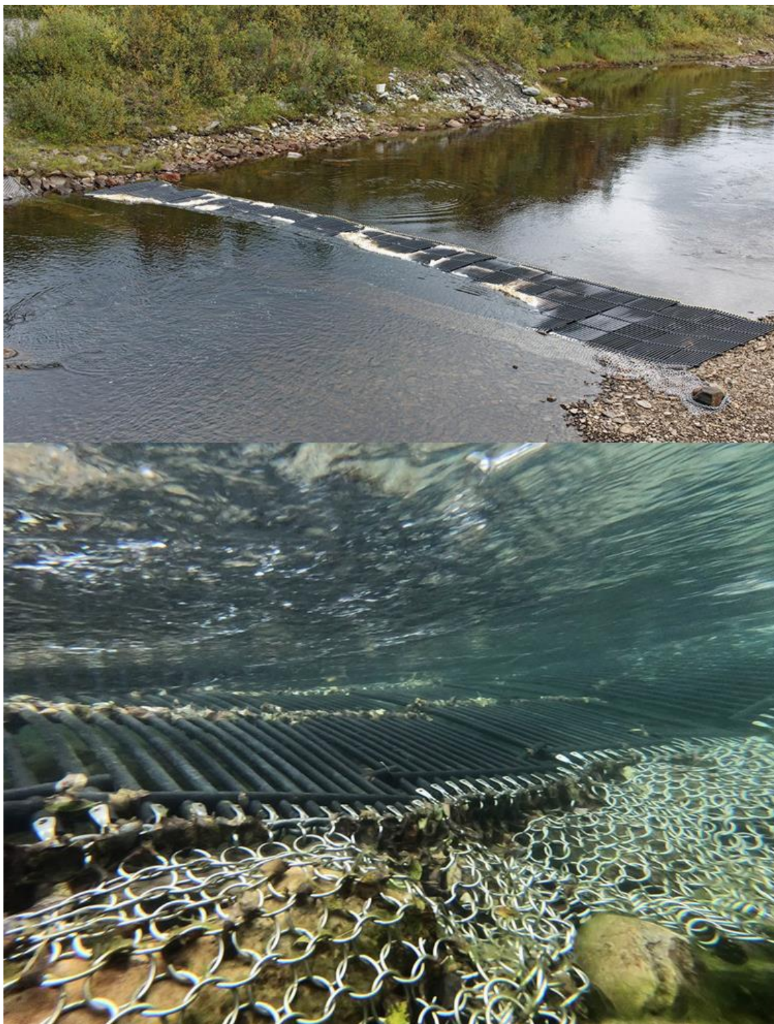
Bildeserie 3. Alta-firmaet River Protection AS har utviklet en fellekonstruksjon med bruk av flytende plastrør (øverste bilde) og metallbrynjer (nederste bilde). Dette fellekonseptet er tenkt benyttet i elver av ulik størrelse. Begge foto: River Protection AS.
