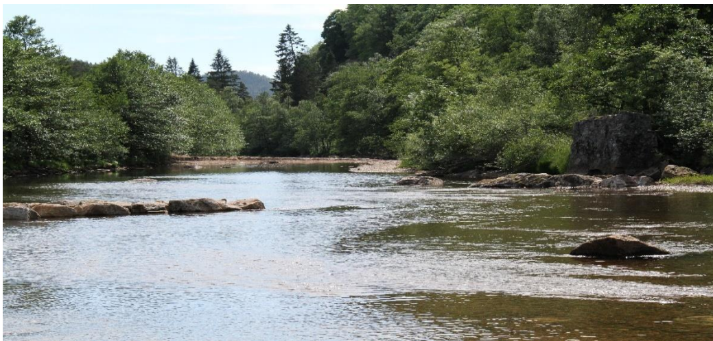
På Gislefoss, ca 300m nord for selve fossen ble det fjerna ca. 150m 3 med elvegrus, samtidig som det ble bygd buner og lagt ut steingrupper og døde trær.
