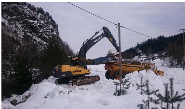
Utkjøring av stein fra deponi på Gislefoss
