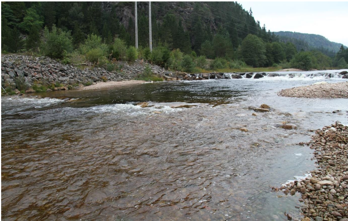
Ny terskel med markert lavtvannsrenne.
