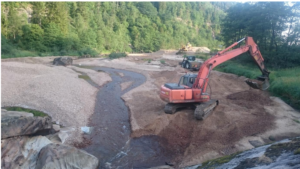
Arbeid med fjerning av grusmassene ovenfor Gislefossen.
