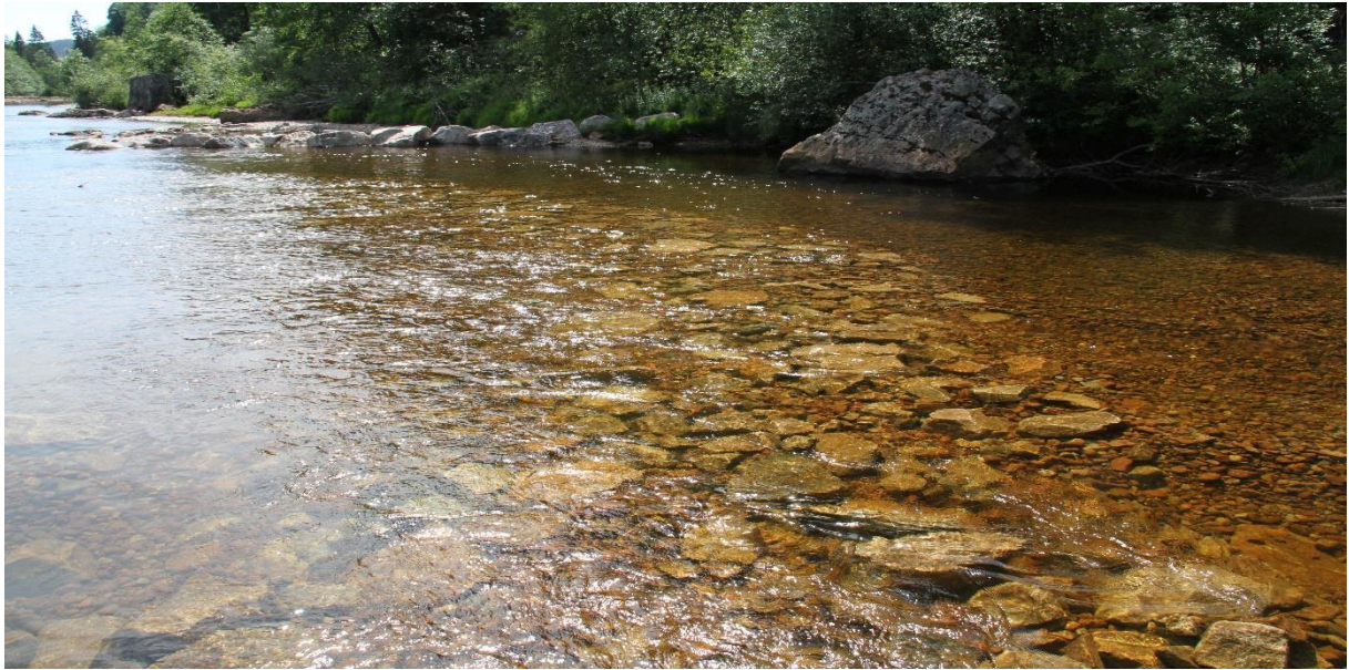
Steinsetting av bunn i kombinasjon med buner.
