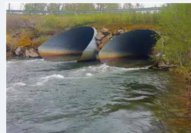
Storjord bru, som hindrer fiskevandring, er tatt inn i tiltaksprogrammet 2022–2027 fra Regional vannforvaltning. Måselv kommune har fullført planleggingsfasen, og oppstart forventes snart. Rørene skal erstattes med bru i denne sentrale delen av elva.
