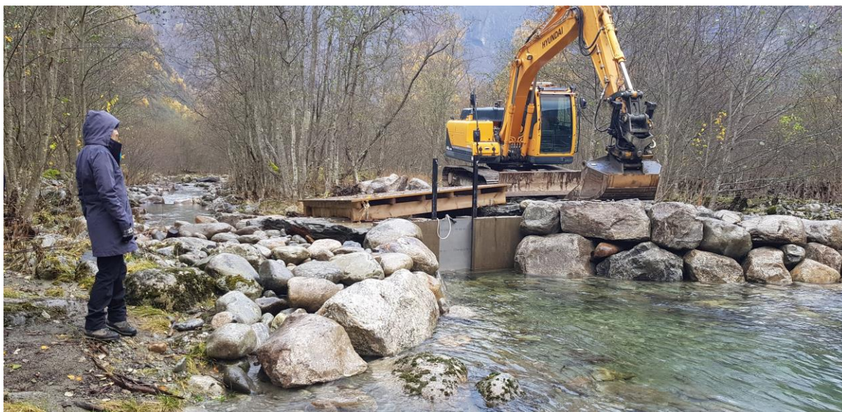
Figur 81. Eksempelbilde av et justerbart betonginntak under bygging
