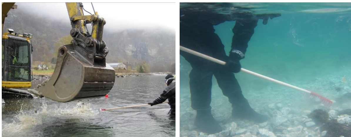
Figur 78. Utlegging av gytegrus i Aurlandselva (venstre) og finjustering av en gyteplass (høyre)
