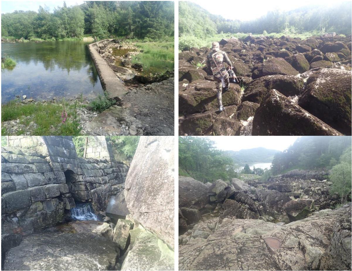
Figur 44. Øverst: Demningen ved utløpet av Øgreisvatnet (venstre) og tørrlagt stryk nedstrøms demningen (høyre). Nederst: Demningen (venstre) og tørrlagt stryk ned mot Øgreisfossen (høyre).
