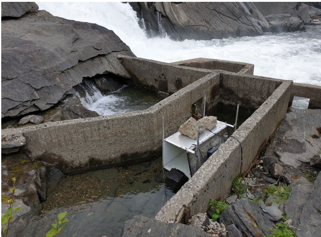
Bilde: Plassering av videotunellen i fisketrappa i Drevja. I forkant av videotunellen er det montert et ledegjerde slik at fisken ikke kan passere utenom. Fisketrappa i Drevja. Fotograf: Aslak Darre Sjørson
