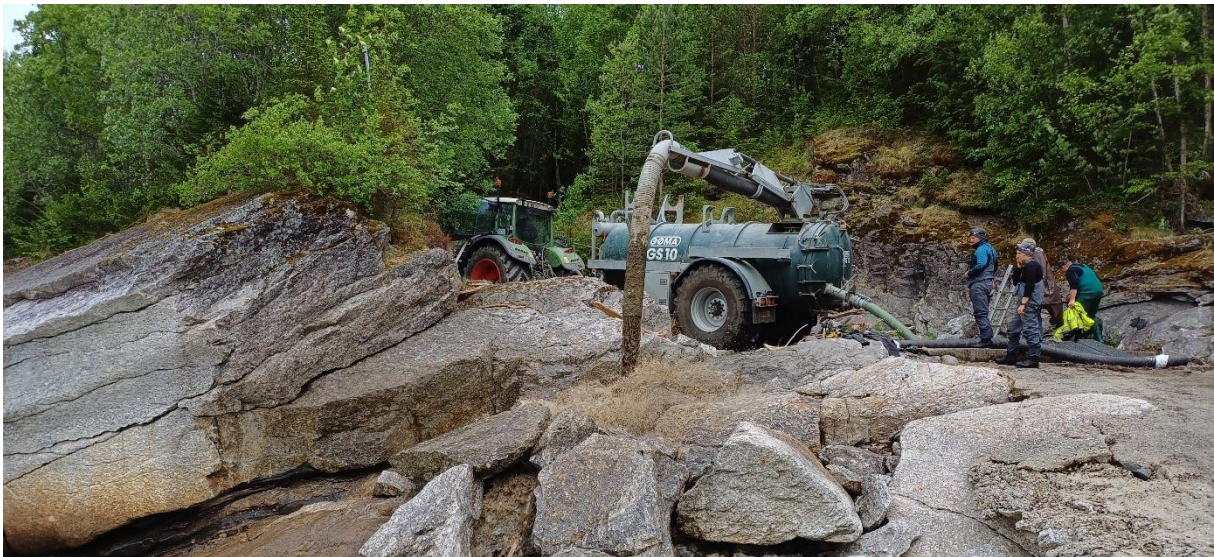
Figur 16. Utpumping av slam från laksetrappa i Tømmeråsfossen.
