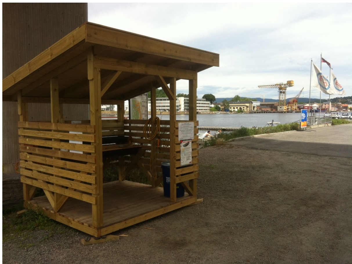
Bildet viser den nye desinfiseringsstasjonen ved Porsgrunn Marina
