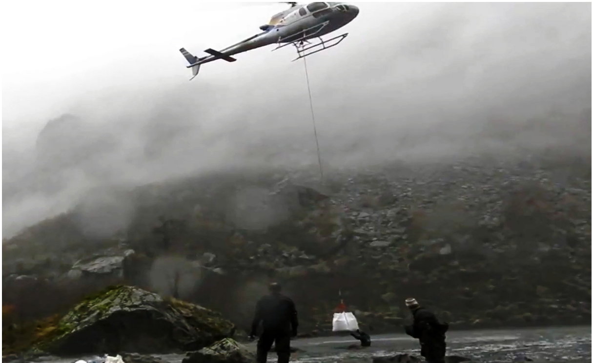
Bilde 2: Utlegging av gytegrus i Frafjordelva
