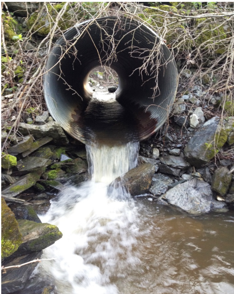
Bilde 15: Kulvert som vandringshinder
