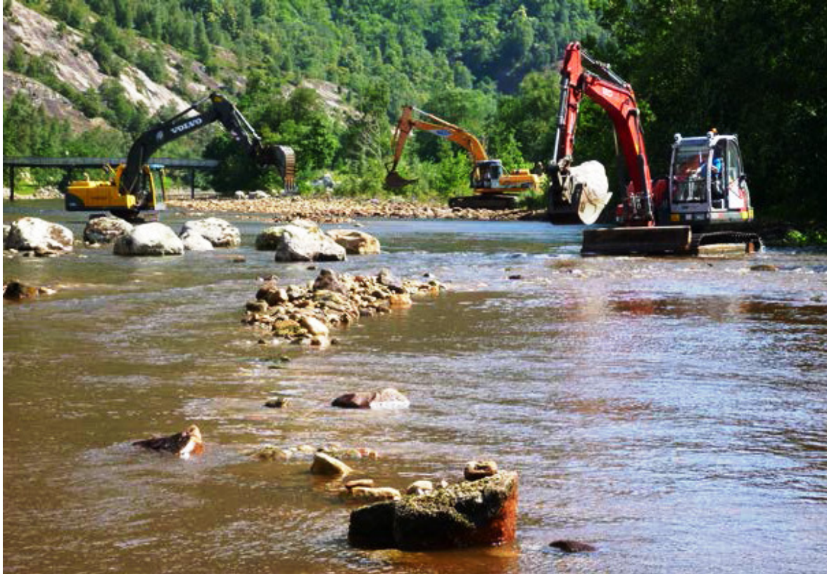
Bilde 8: Utlegging av stein for å skape mer variert elvemiljø i en kanalisert elvestrekning (foto: Ulrich Pulg)
